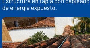
Estructura en tapia con cableado de distribución de energía expuesto.
