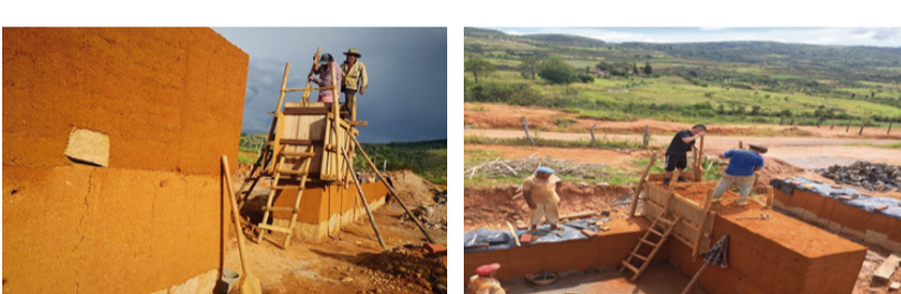
Proceso constructivo tapia pisada
